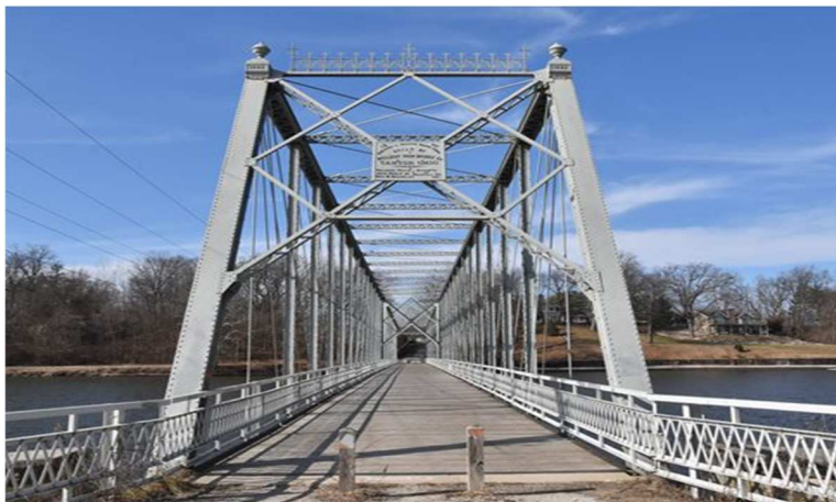
Slika 8. Tioga bridge, PA.
